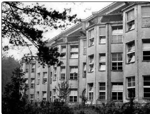
Budynek sanatorium w Jaroszowcu. Lata pięćdziesiąte. fot. Arch. WSChP. (ryc. 3)
