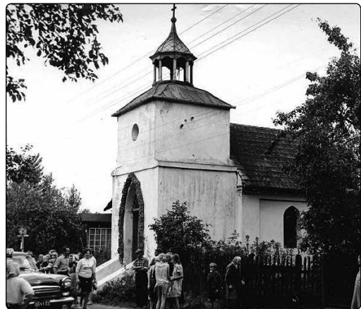
Tlukienka. Kaplica przed pożarem w grudniu 1971 r. (ryc. 7)
