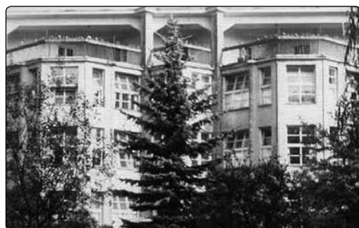
Budynek sanatorium w Jaroszewcu. Lata pięćdziesiąte. fot. Arch. WSCbP. (ryc. 1)
