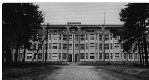
Budynek sanatorium w Jaroszewcu. Lata pięćdziesiąte. fot. Arch. WSCbP. (ryc. 2)
