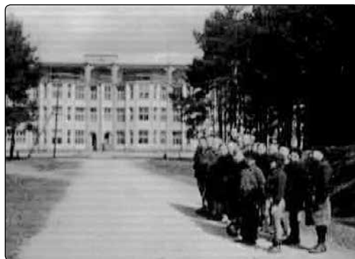
Budynek sanatorium w Jaroszowcu. Lata pięćdziesiąte. fot. Arch. WSChP. (ryc. 4)
