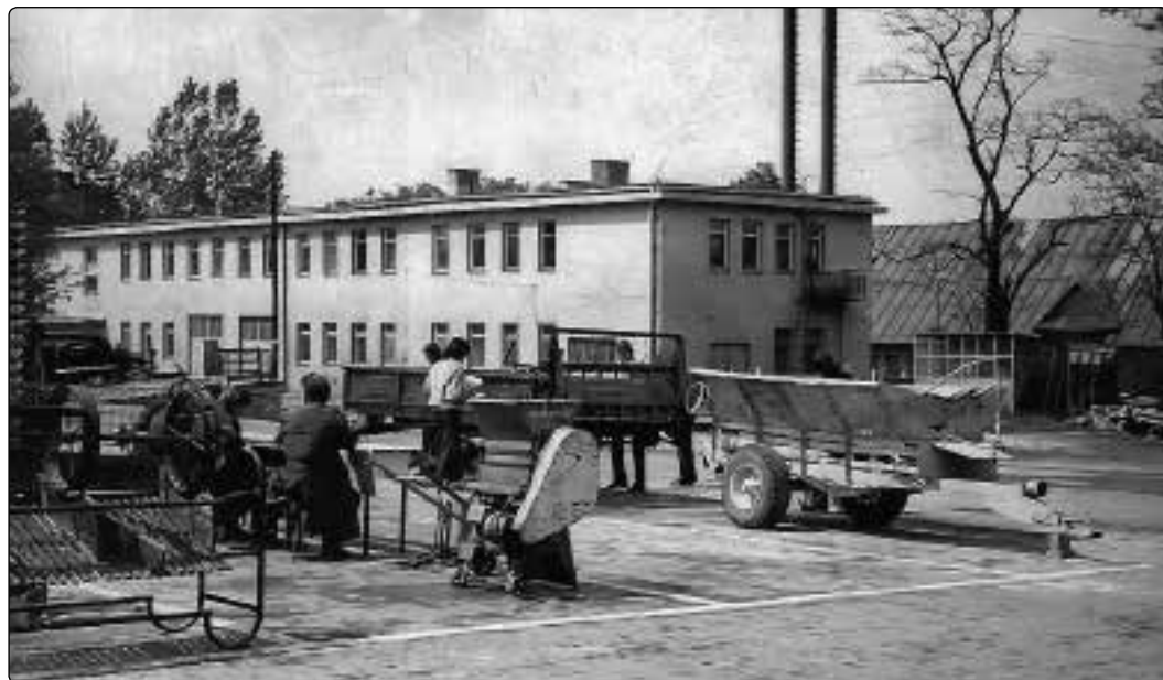
Il. 9. Państwowy Ośrodek Maszynowy. W tle widoczny budynek szatni. Źródło: Fotografia ze zbioru Mieczysława Cader.
