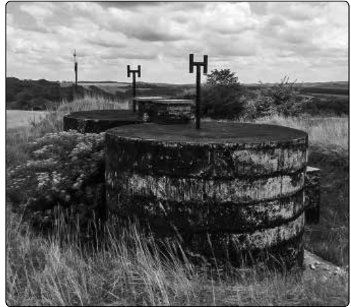
Il. 11. Zbiornik na wodę (obecnie już nie pełni swojej funkcji) zbudowany w dole, jaki wykopano podczas budowy bunkra (nie został ukończony), fot. Jacek Sypień
