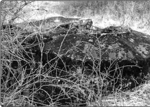
Il. 6. Bunkier Ringstad na polach w okolicy Chrzęstowic koło wieży telekomunikacyjnej
