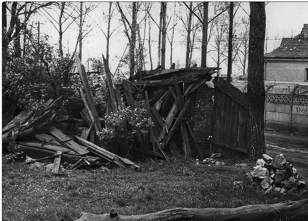
Il. 10. Pozostałości wozowni od strony południowo-wschodniej (widoczny dach hotelu robotniczego i blok nr 1 w lasku fabrycznym - jest to jedyne zachowane zdjęcie, ukazujące wyraźnie dawną lokalizację zabudowań „folwarku” Mroczkowskich)
