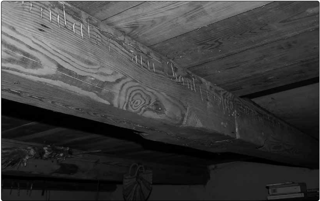
Il. 5. Drewniana belka stropowa
