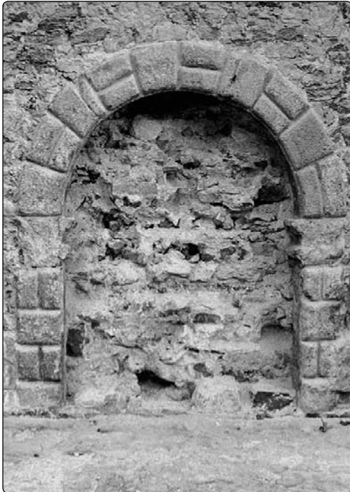
Barokowy portal wejściowy do piwnicy budynku Floriańska 2, w momencie odkrycia w zewnętrznej ścianie północnej, obecnie wewnątrz podziemi kamienicy. Fot. Jerzy Roś
