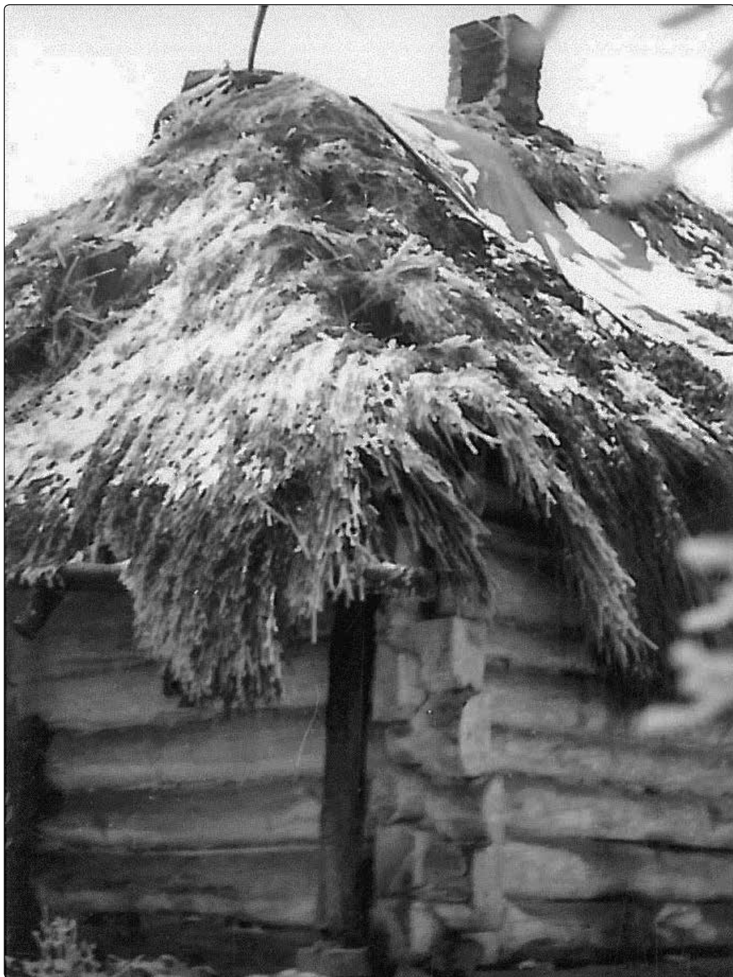
Il. 6. Konstrukcja wieńcowa, węgiel z ostatkami. Fot. E. Żaba
