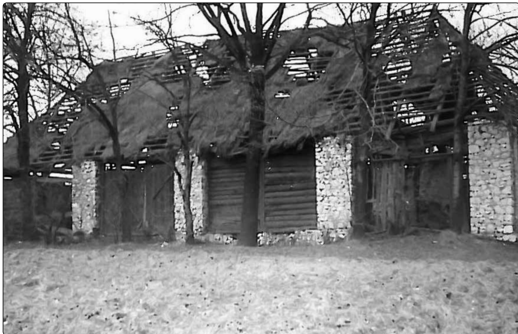
Il. 13. Jangrot – Przykład ściany o konstrukcji sumikowo-łatkowej w stodole dworskiej, ok. 1985 r
