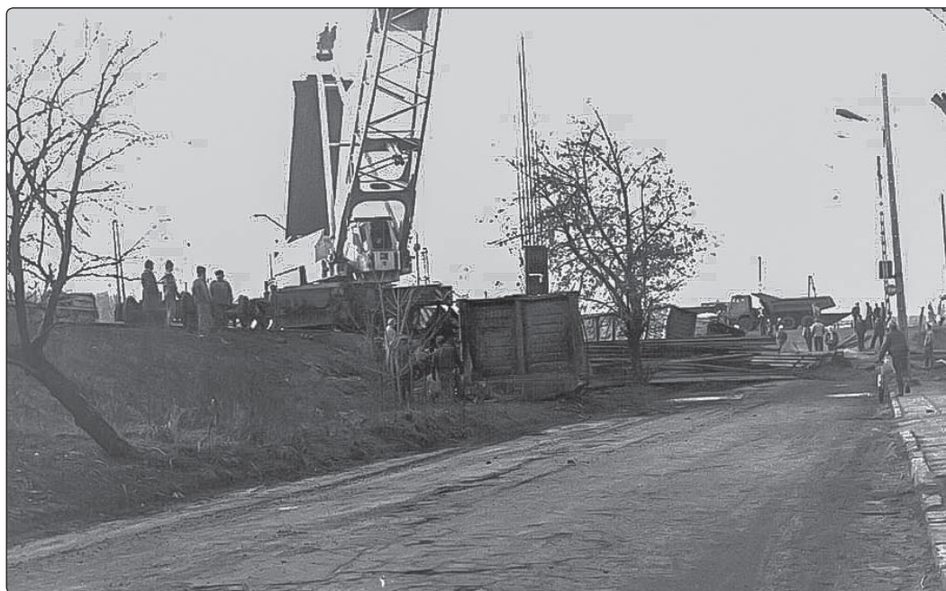
Il. 32. Wolbrom ul. Garbarska - wypadek kolejowy z listopada 1989 r., kiedy wagony pociągu towarowego na linii LHS wykołczyły się i spadły z nasypu na ulicę. Zdjęcie ze zbiorów Ignacego Kopcia.
