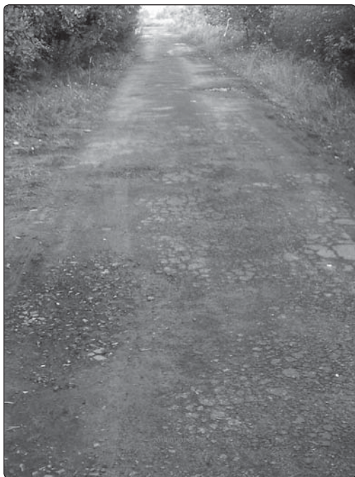
Il. 27. Kaliś - fragment starej drogi stan obecny (wrzesień 2021 r.) w okolicach cmentarza żołnierzy z I wojny światowej. Widok w kierunku Wolbromia. Z lewej strony widać ile już zarosła stara droga. Cóż przyroda robi swoje...
