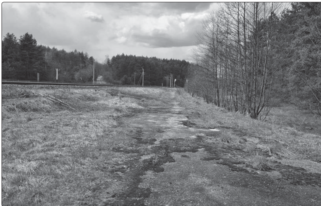
Il. 18. Chrząstowice – stan obecny (październik 2021 r.) starej drogi pomiędzy Białą Przemszą, a torami kolejowymi w kierunku Olkusza. Na przecięciu drogi i torów znajdował się drugi opisany w artykule przejazd kolejowy. Widać jak trawa zarasta drogę...- zdjęcie Pani Agnieszka Tabor z Chrząstowic.
