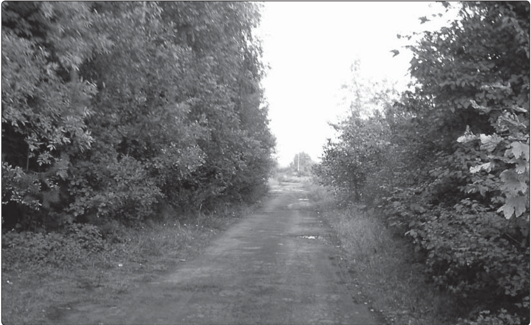
Il. 26. Kaliś - stan obecny (wrzesień 2021 r.) na końcu tego odcinka starej drogi był piąty dawny przejazd kolejowy. Widok w kierunku Wolbromia
