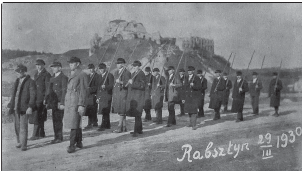
Il. 29. Droga w Rabszynie 1930 r. Widać na zdjęciu nawierzchnię szutrową drogi. Zdjęcie ze zbiorów PTTK Olkusz
