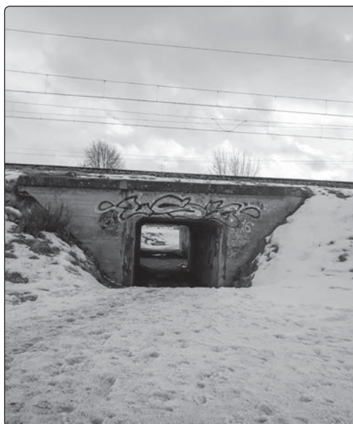
Il. 33. Wolbrom – stan obecny (luty 2022 r.) przejścia podziemnego przy ul. Garbarskiej
