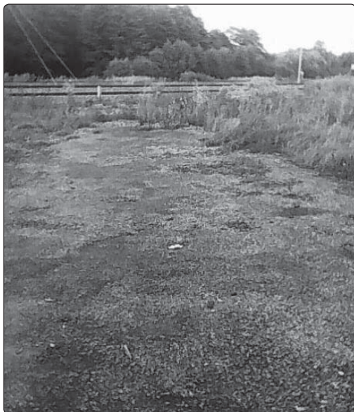
Il. 16. Chrzęstowice – tu znajdował się drugi z przejazdów kolejowych jadąc od strony Olkusza. Stan obecny (wrzesień 2021 r.) starej drogi. Widok w kierunku Wólbromia
