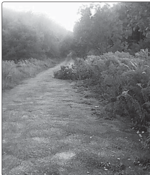
Il. 17. Chrzęstowice – stan obecny (wrzesień 2021 r.) starej drogi na odcinku od dawnego przejazdu kolejowego do obecnej drogi Olkusz-Wólbrom. widok w kierunku Olkusza. Na drodze zalega złamana gałąź.
