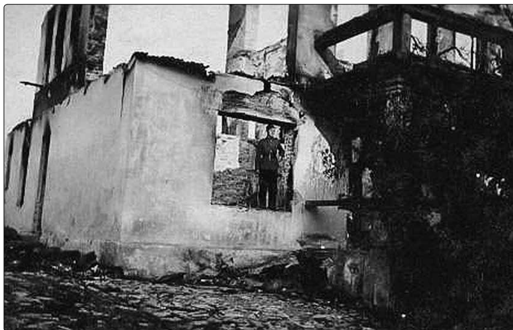
Il. 6. Spalony budynek doktora Łapińskiego i miejsce stracenia, fot. arch. Muzeum Regionalne PTTK w Olkuszu
