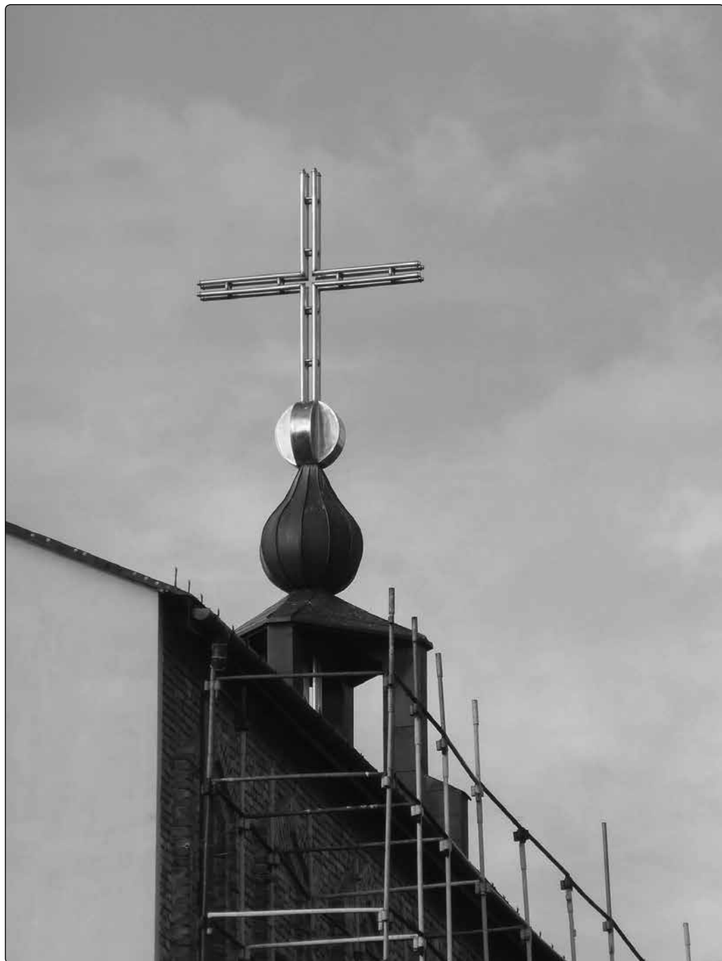
Il. 7. Wieżyczka zwieńczona krzyżem - dzieło pracowników koksowni „Przyjaźń”. Fot. E. Matyszkowicz
